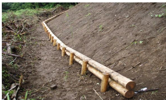
利用事例（簡易丸太柵：土留め）
