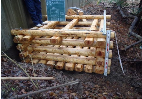
利用事例（木製沈床工）
