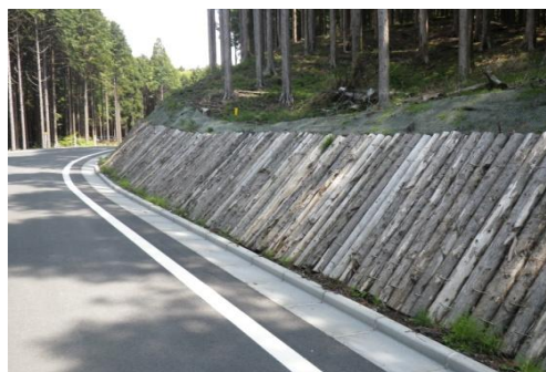
利用事例（丸太伏工：現場発生材利用）
