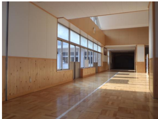
内装木質化事例（伝法小学校校舎）
