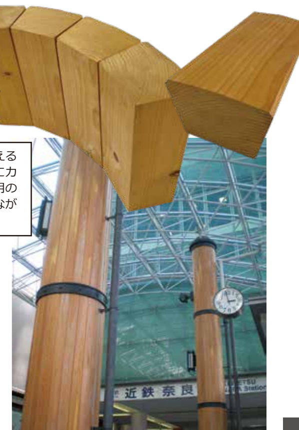
ボルト加工(穴埋め後)
