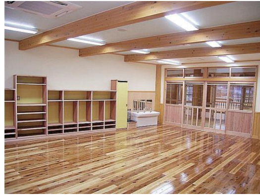
スギの圧縮材を利用した事例
